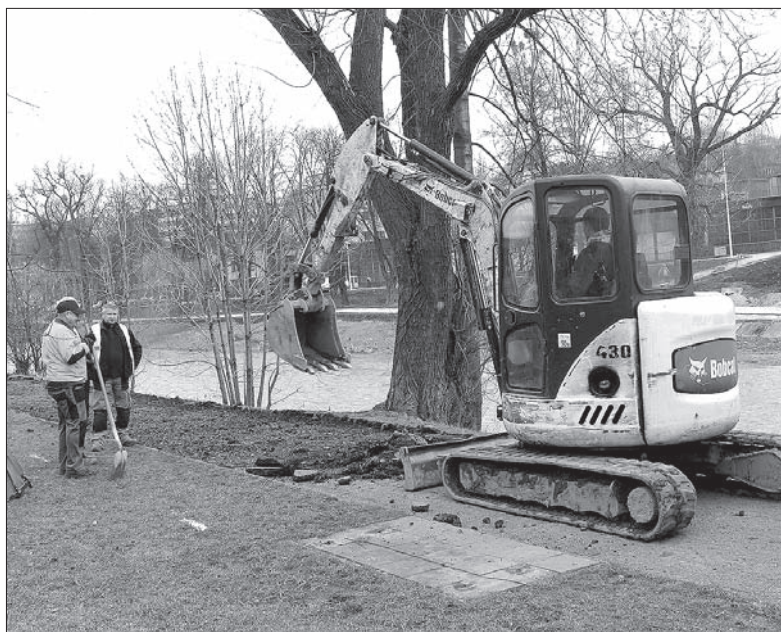
Na nabrzeżu Olzy w Czeskim Cieszynie ruszyły prace budowlane.
