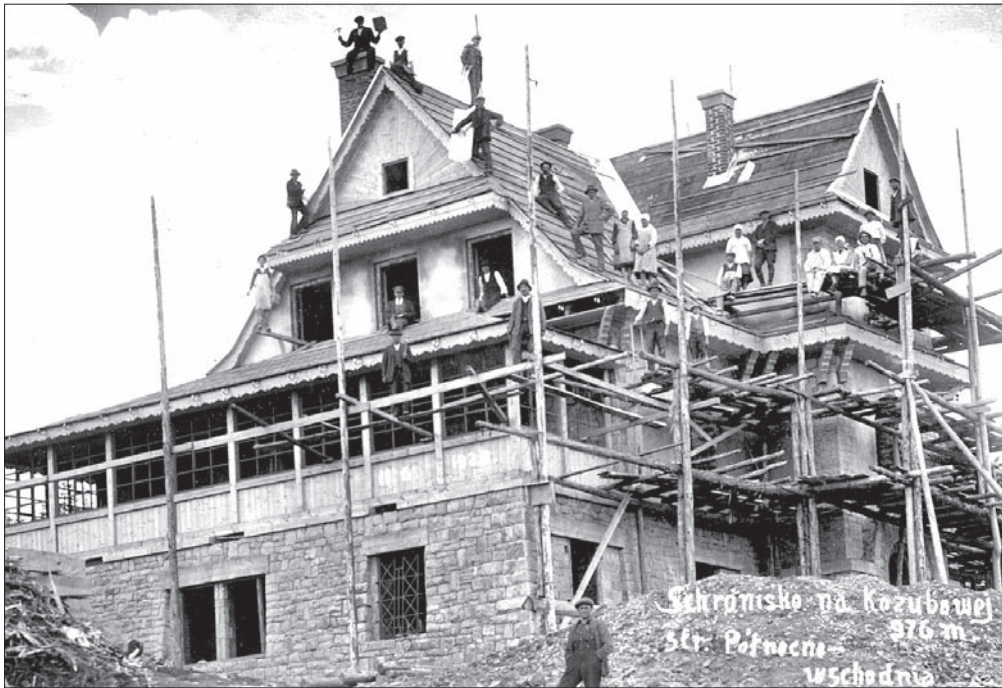
Budowa schroniska na Kozubowej, czerwiec 1929 r.
