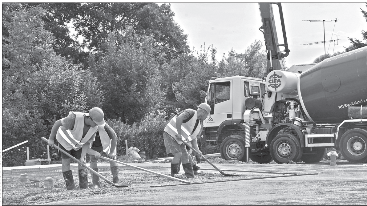
Fot. DANUTA CHLUP Wylewanie płyty fundamentowej.
