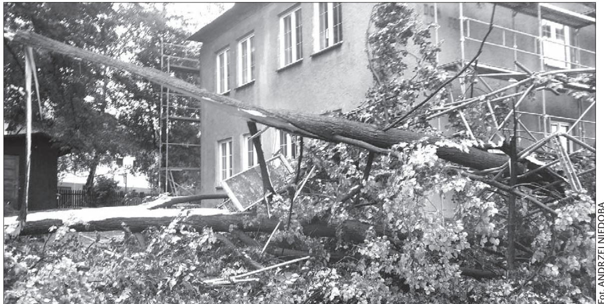
Wichura zniszczyła rusztowania wokół domu PZKO, w którym właśnie remontowany jest dach.
