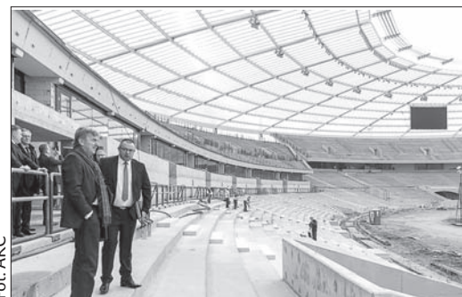
Fot. ARC Zmodernizowany Stadion Śląski w Chorzowie ma być gotowy za półtora roku.
