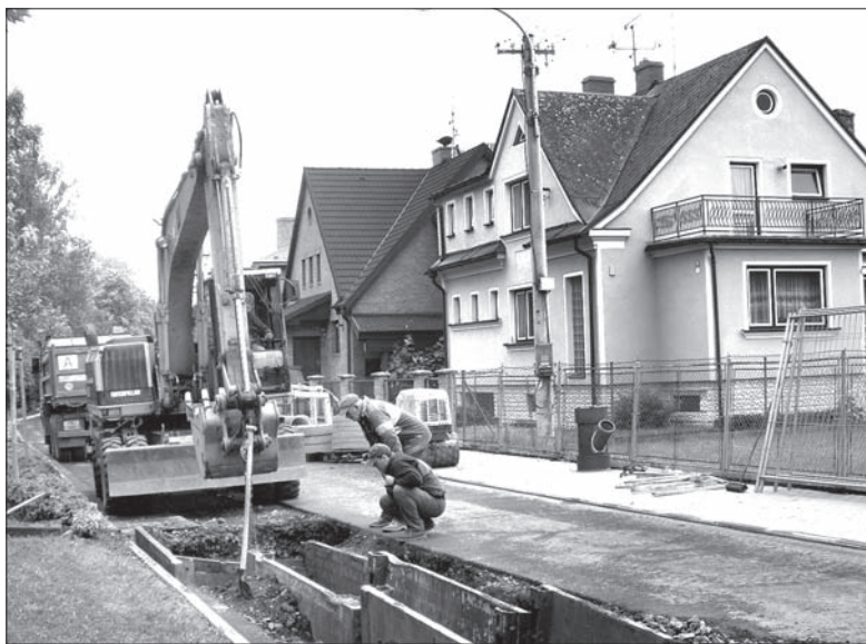
Aleja Wolności jest rozkopana. Robotnicy kładą nowe rury kanalizacyjne.
