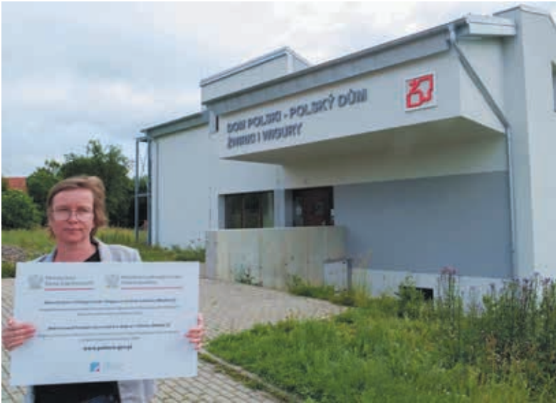
• Odnowiony budynek z białą-kremową elewacją i odświeżonym napisem stał się estetyczną wizytówką okolicy. Fot. ŁUKASZ KLIMANIEC
