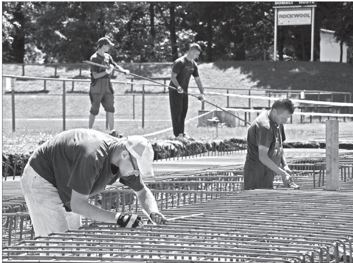
Zbrojenie płyty nowej trybuny w Boguminie.
