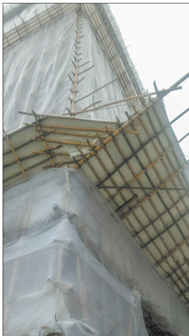
Rusztowanie z bambusa jest w Chinach rzeczą normalną.
