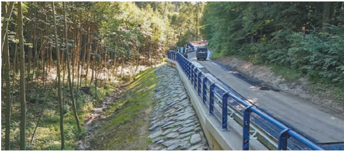
• Droga z Cierlicka do Sobieszowice jest już przejezdna. Fot. Materiały prasowe wykonawcy
