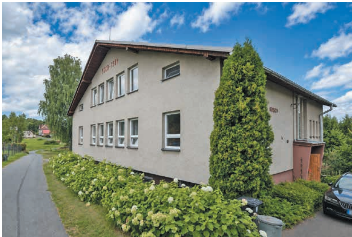
• Dzięki przyznanej dotacji wymieniony zostanie dach Domu PZKO w Milikowie, a klatka schodowa zmodernizowana. Fot. Google Maps
